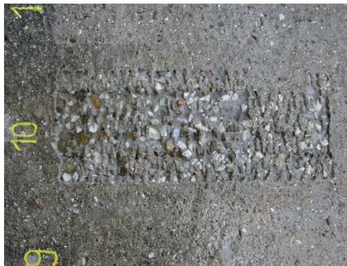
Rys. 4. Bruzda utworzona na powierzchni płyty drogowej przez pulsacyjny oscylacyjny strumień uzyskany za pomocą urządzenia Aqua Cutter Robot HVD-6000. Zastosowano wahadłowy ruch dyszy. Wytrzymałość betonu na ściskanie wynosiła 40 MPa
