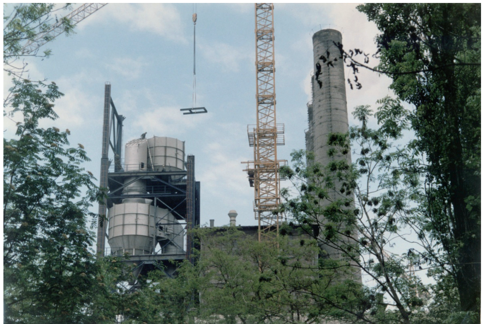
Fot. 7. Budowa wieży cyklonowych wymienników ciepła
