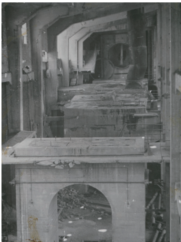
Fot. 3. Zniszczenia Cementowni „Odra” po II wojnie światowej
