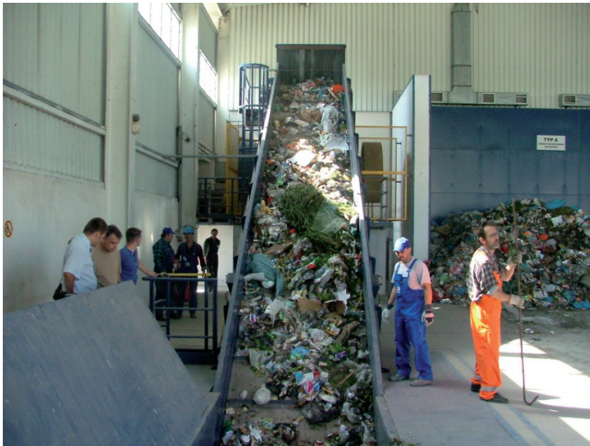
Fot. 8. Linia do segregacji odpadów komunalnych
