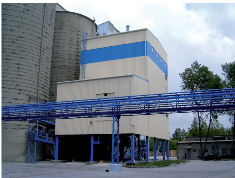
Fot. 9. Terminal załadowczy cementu
