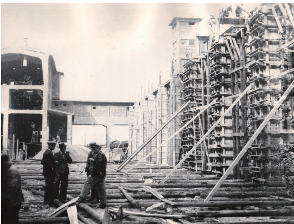
Fot. 5. Budowa hali klinkieru
