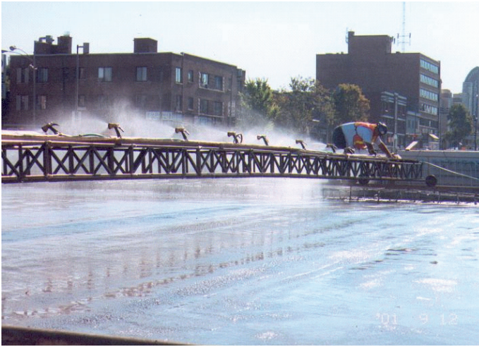
Rys. 10. Zapobieganie skurczowi plastycznemu za pomocą pielęgnacji mgłą.
