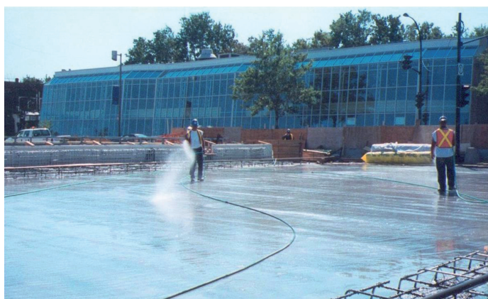
Rys. 12. Tak, im zapłacono za wodną pielęgnację betonu i starannie ją stosują.
