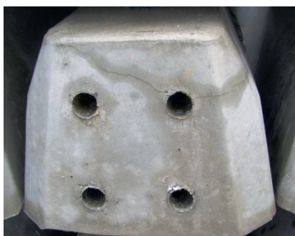
Rys. 6. Rozrywanie strunobetonowego podkładu kolejowego Fig. 6. Bursting in the pre-tensioned concrete railway sleeperj
