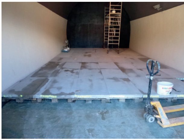
a: Układanie nawierzchni drogi a: Laying of concrete road
