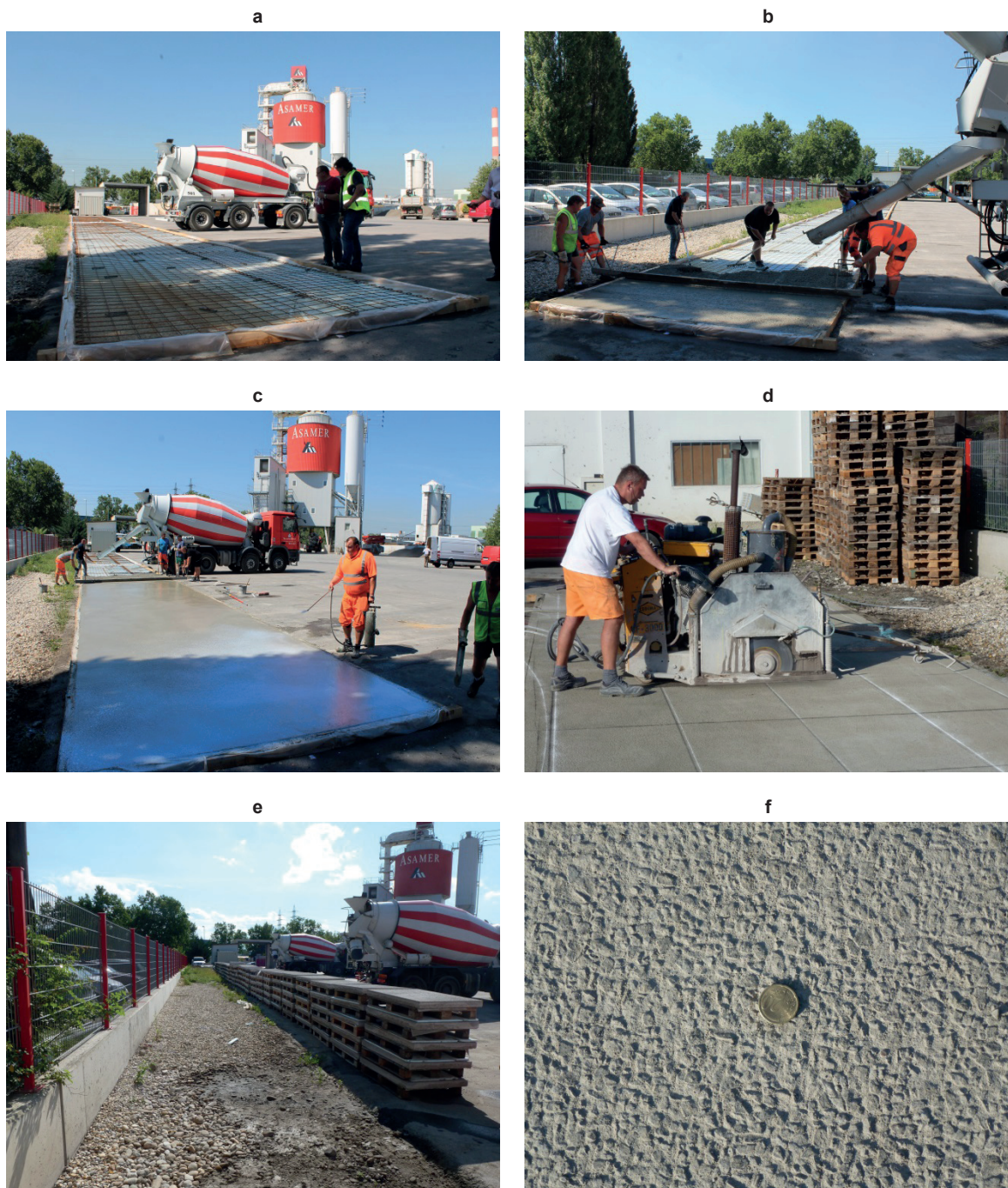
Rys. 5. Budowa nawierzchni betonowej do tunelu doświadczalnego
