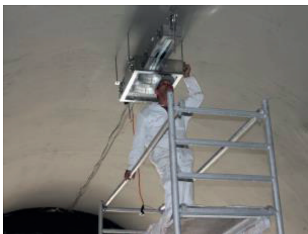
c: Instalacja lamp / Installation of lamps
