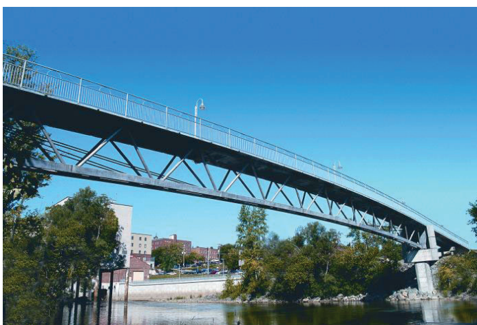
Rys. 1. Kładka pieszo-rowerowa w Sherbrooke w Kanadzie (15)
