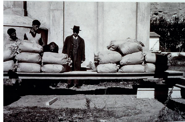
Fot. 4. Badania prefabrykowanych belek sprężonych
