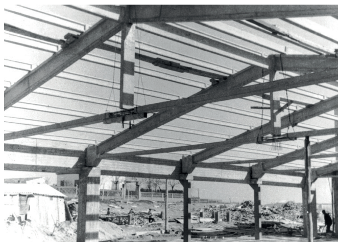
Fot. 8. Prefabrykowane kratownice dachowe
