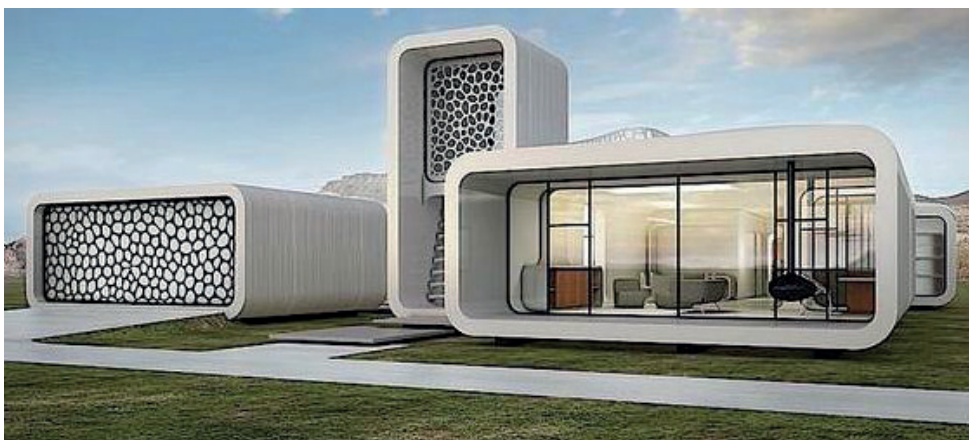
Fot. 16. Druk przestrzenny zastosowany do budowy domu z prefabrykatów
