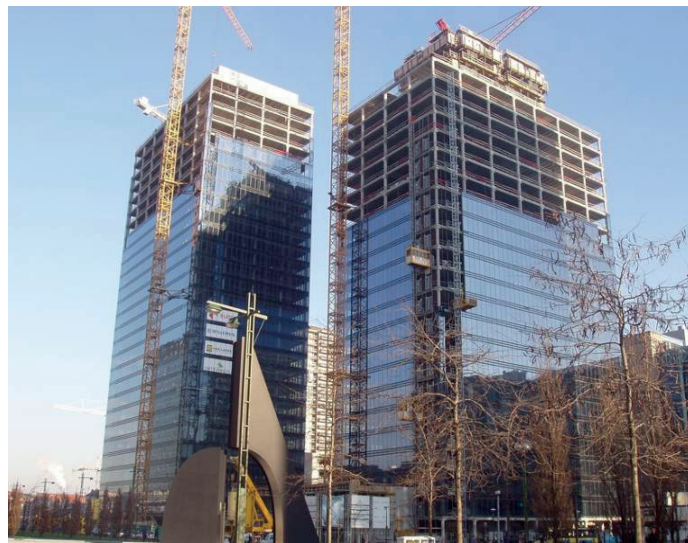
Fot. 13. Prefabrykowany biurowiec
