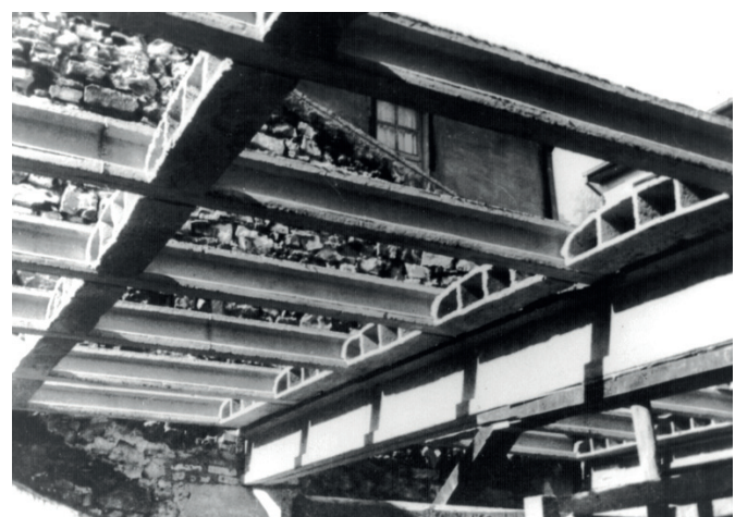
Fot. 6. Belki sprężone, którym towarzyszą nowe, w tamtych czasach, bloki betonowe
