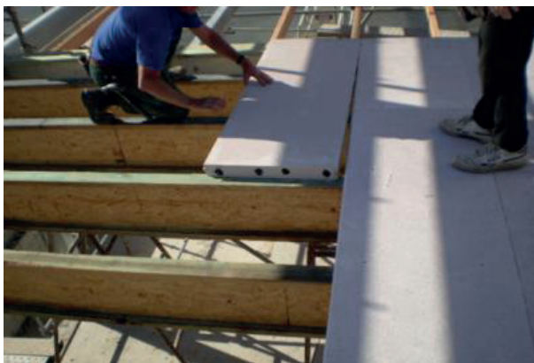
Rys. 13. Strop z ABK na konstrukcji drewnianej
