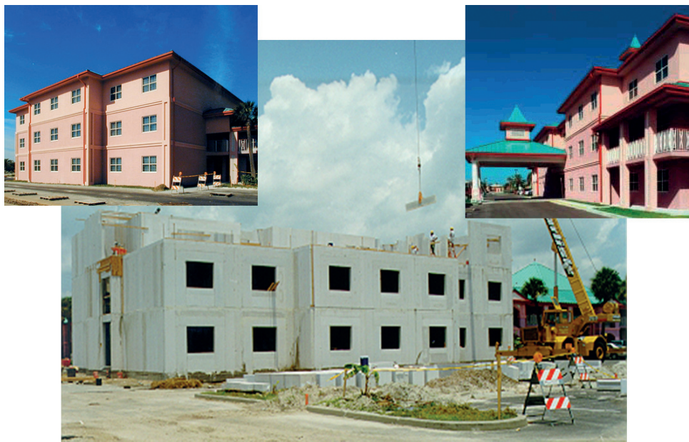
Rys. 17. USA; Hotele zbudowane z ABK, ze zbrojonych paneli na ściany i stropy
