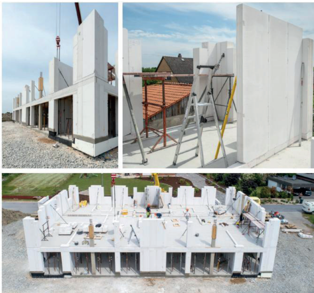
Rys. 6. Budynek piętrowy z ABK, z elementami monolitycznymi
