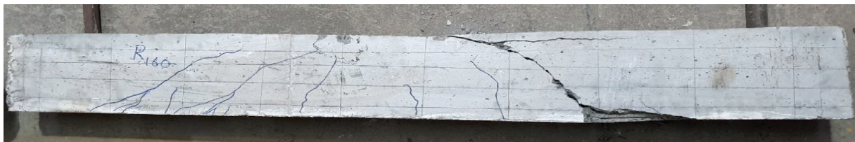
b) R160 Wzorzec pęknięcia belki - zniszczenie przez ścinanie b) R160 Beam crack pattern at ultimate – failed in shear
