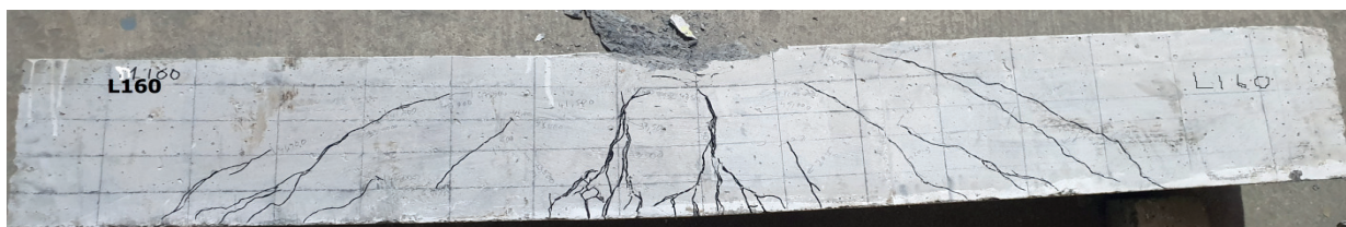
d) L160 Wzorzec pęknięcia belki - zniszczenie przez zginanie d) L160 Beam crack pattern at ultimate – failed in flexure
