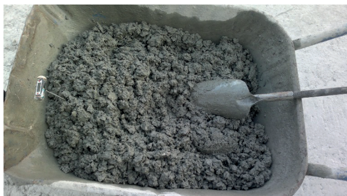
Rys. 2. Mieszanka betonowa zawierająca 50% kruszywa grubego płaskiego
