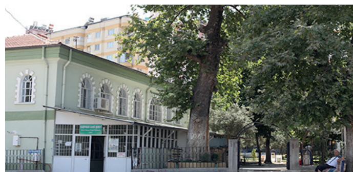
Rys. 1. Widok meczetu Hacı Hasan Feyzi przed usunięciem tynku
