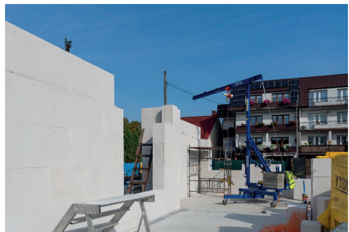
Rys. 3. Wykorzystanie miniżurawia na budowie z betonu komórkowego [fot. Xella Polska sp. z o.o.]
