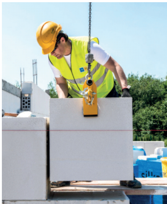
Rys. 1. Budowa z elementów wielkoformatowych z betonu komórkowego [fot. Xella Polska Sp. z o.o.]
