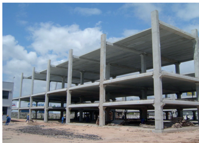
Rys 1. Realizacja budynku szkieletowego ze stropami z płyt HC
