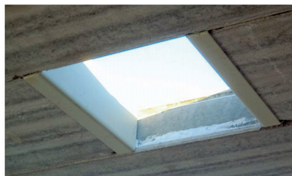
Rys. 4. Przykładowy wymian stalowy firmy PEIKKO PETRA (18)
