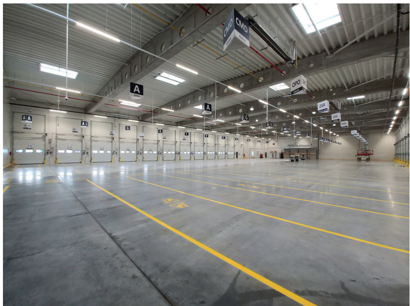
Rys. 17. Przykład hali cross-dockingowej dla firmy Panattoni w Kielcach [fot. Pekabex]
