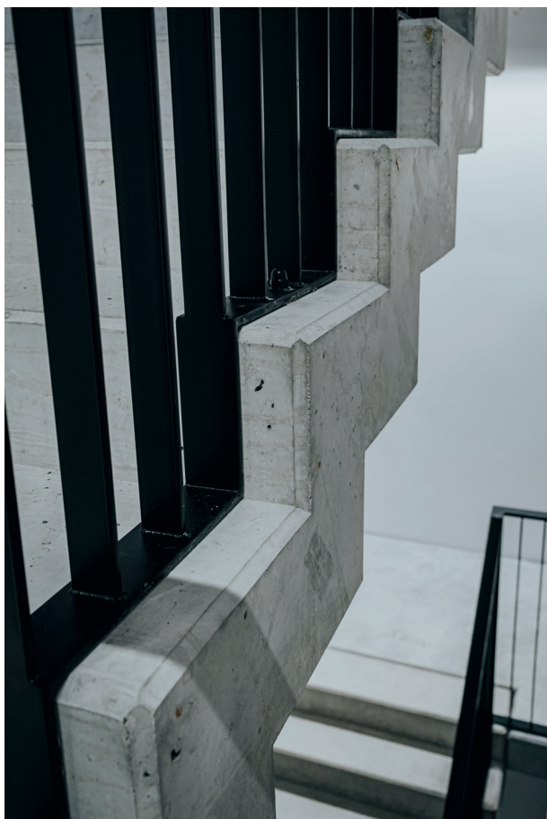
Rys. 11. Prefabrykowane schody dywanowe budynku L.I.T. w Zielonej Górze [fot. Pekabex]
