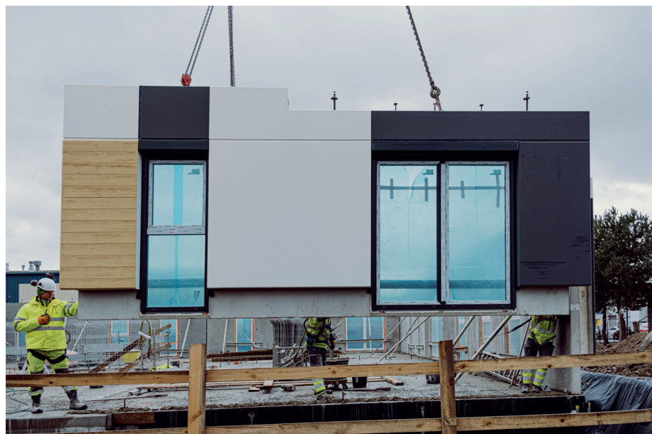
Rys. 6. Montaż trójwarstwowej ściany prefabrykowanej, Osiedle Ja_Sielska w Poznaniu [fot. Pekabex]
