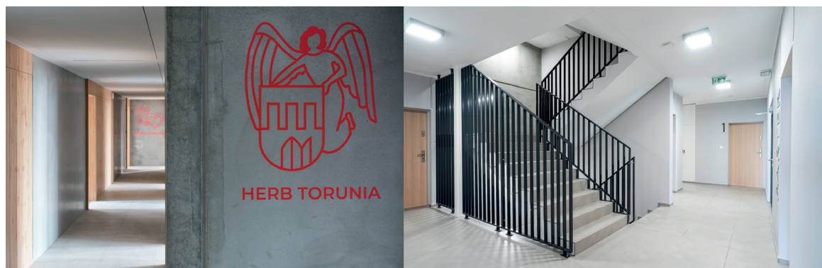
Rys. 10. Klatki schodowe budynków: przy ul. Okólnej w Toruniu oraz przy ul. Jasielskiej w Poznaniu [fot. Pekabex]
